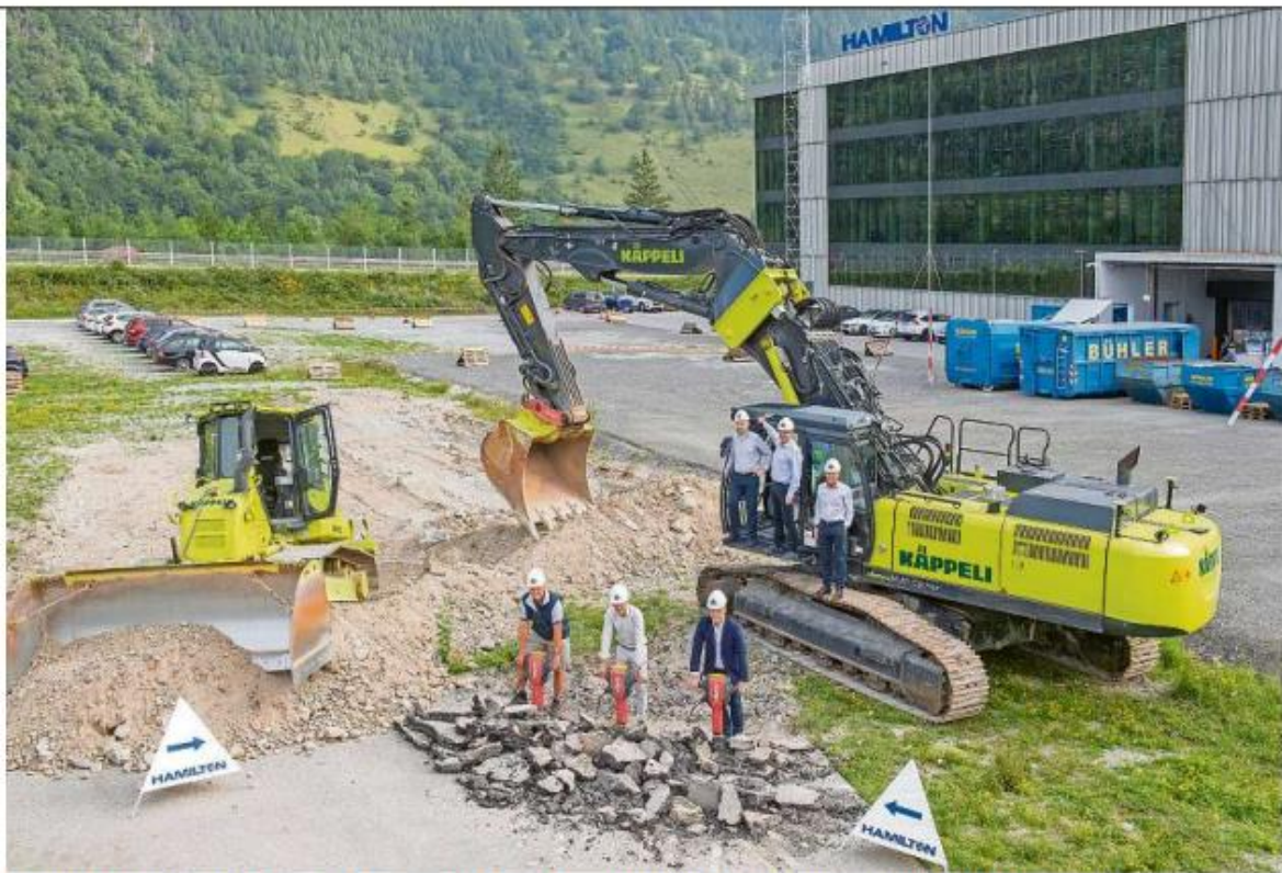
Mit Presslufthammer und Bagger: Beim Spatenstich sind Vertreter der Bündner Regierung, der Hamilton und der Gemeinde Domat/Ems vor Ort.
